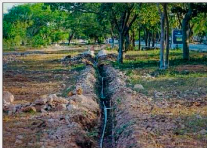
Arriba, la alcaldesa Cecilia Patrón Laviada en la presentación de las obras del corredor verde de Ciudad Caucel. A la izquierda, una vista de los trabajos. El proyecto ya cuenta con un avance del 90 por ciento
