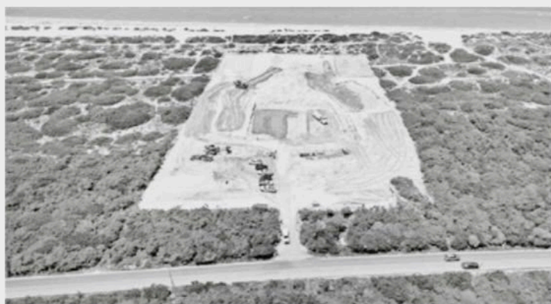
LAS INSPECCIONES efectuadas en materia de impacto ambiental y en materia forestal en Chuburná Puerto permitieron documentar que el desarrollo ya había realizado trabajos de desmonte, despalme y movimiento de arena para la construcción de plataformas.
