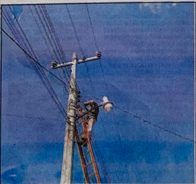
Trabajadores atienden calles con fallas de energía. (POR ESTOI)
