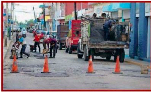
LAS CUADRILLAS de chambeadores del ayuntamiento se fajan tapando los hoyos
