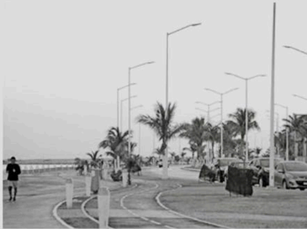
LA OBRA también buscará mejorar la imagen urbana y fortalecer la movilidad no motorizada.
