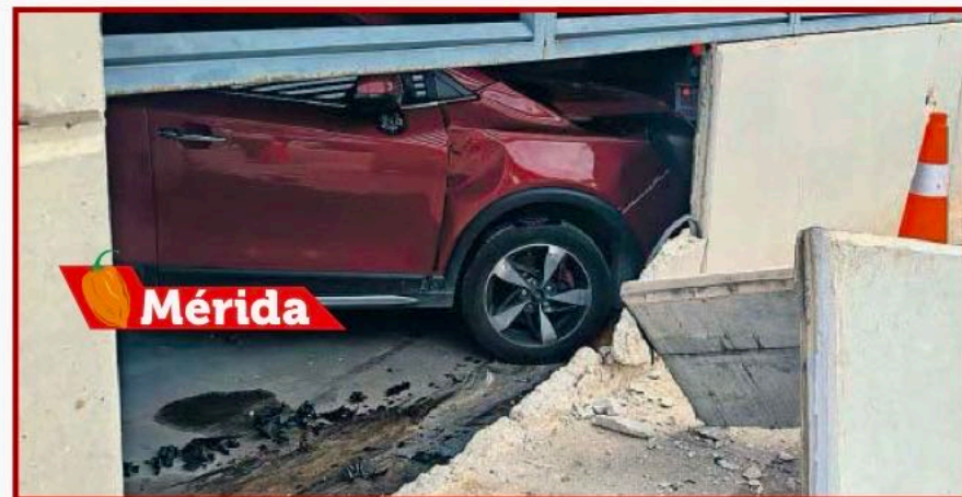
LAS PLACAS de concreto acabaron volando hacia la calle y la doñita seguro con un buen susto
