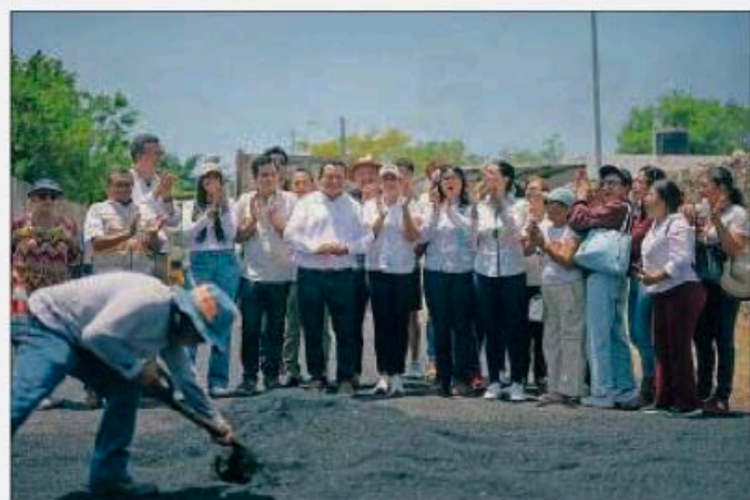
El gobernador Joaquín Díaz Mena, acompañado de funcionarios públicos, en las obras de bacheo en las calles de la colonia Leandro Valle
