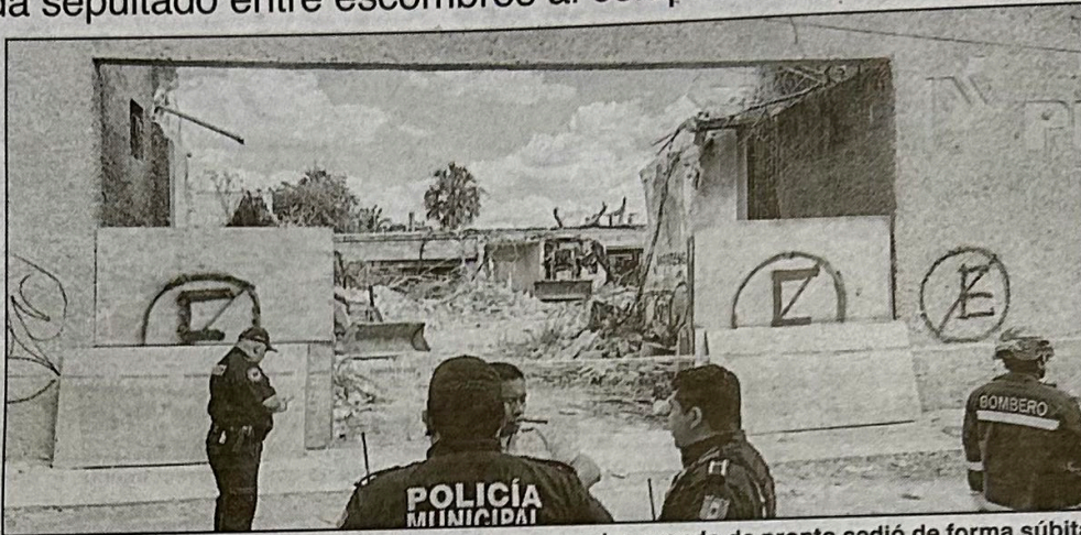
Dos alba iles se encontraban sobre la estructura superior cuando de pronto cedi  de forma s bita.
