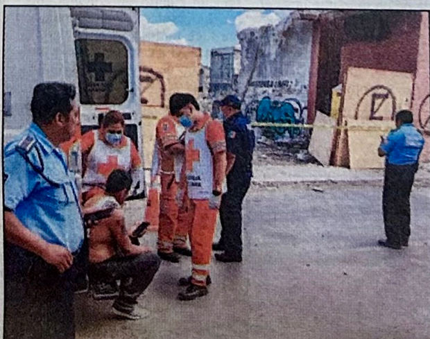
EL incidente ocurrió en un inmueble ubicado en la calle 48 entre 55 y 57 del Centro Histórico meridano; las autoridades investigan las causas del derrumbe.- (POR ESTO!)
